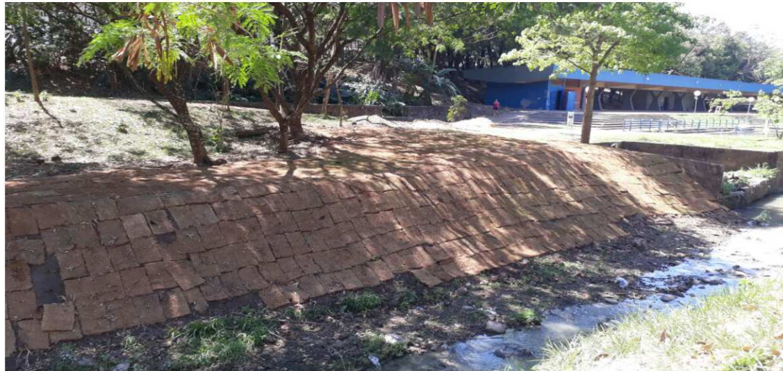
A imagem acima mostra as margens do córrego sendo revitalizada após um longo período de erosão.
