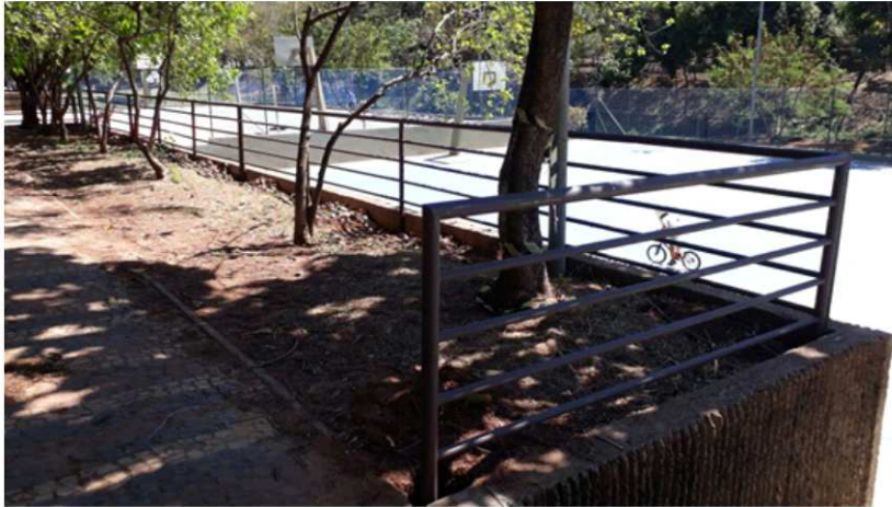
Pintura do guarda corpo com acesso para as quadras poliesportivas.
