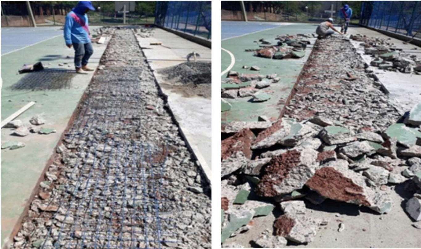
Quadras poliesportivas do Bicão sendo revitalizadas.
