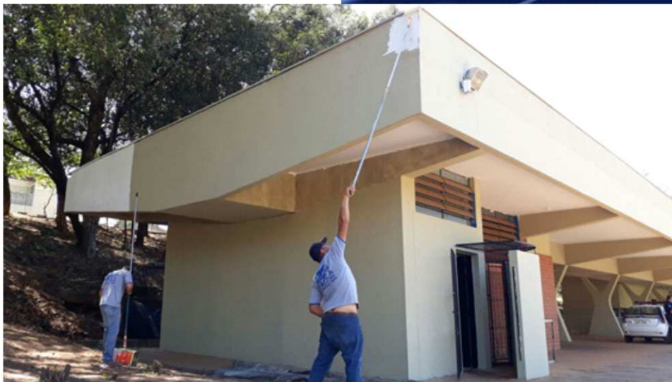
Revitalização da marquise com novo visual.
