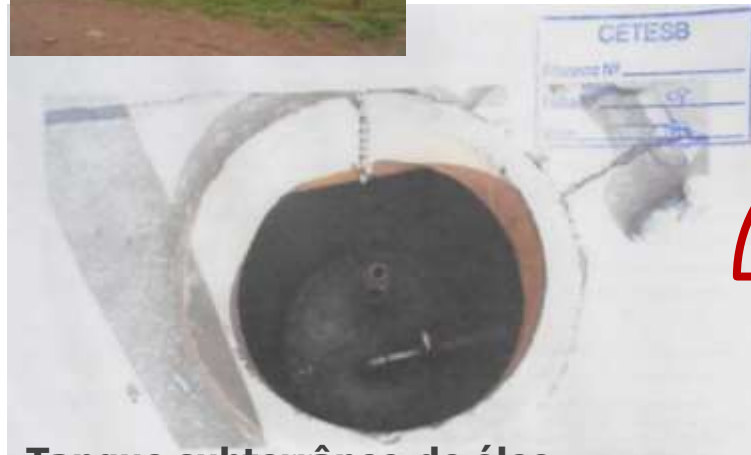
Tanque subterrâneo de óleo mineral que contém "Ascarel" 30 mil litros
